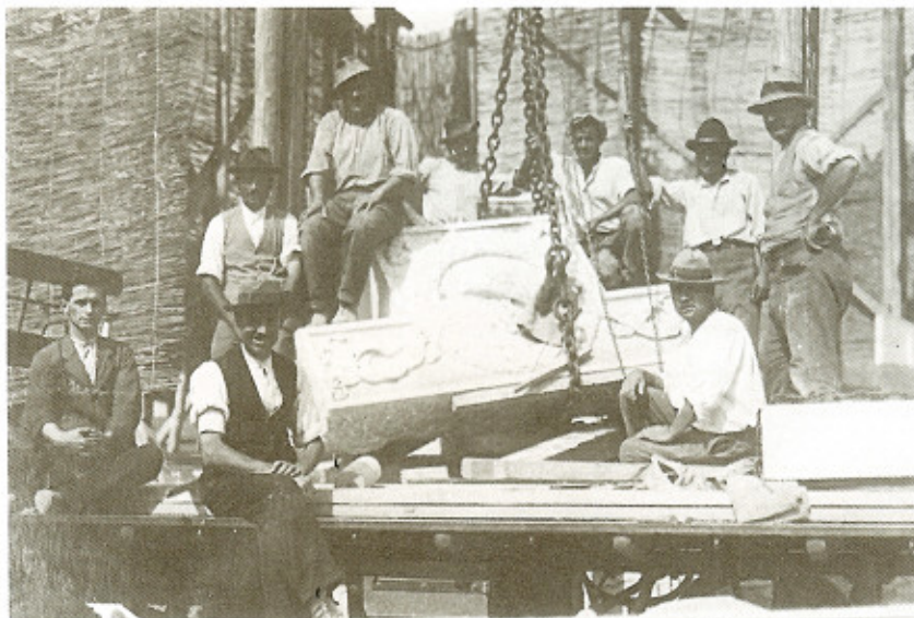
Operai durante la costruzione del Monumento ai caduti di Borgo San Lorenzo - Archivio A. Giovannini
